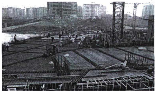
Hình 1.1. Công trình xây dựng Keangnam Tower Hà Nội (Cao 70 tầng với 4 tầng hầm được thi công theo phương pháp đào hở).
