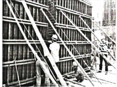
Hình 1.6: Bộ ván khuôn lắp ghép
