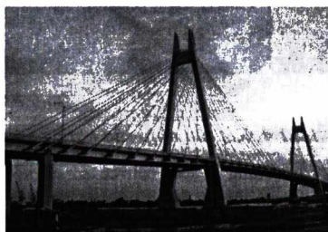
Hình 1.7. Cầu dây văng
