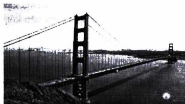
Hình 1.8. Cầu dây võng
