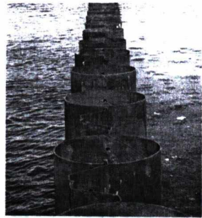
Hình 1.6. Cừ thép với cọc ống thép
