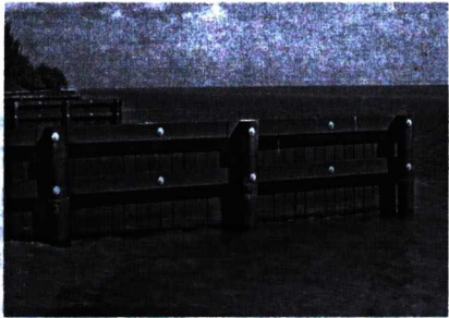
Hình 1.4. Cừ gỗ ứng dụng trong kè mỏ hàn
