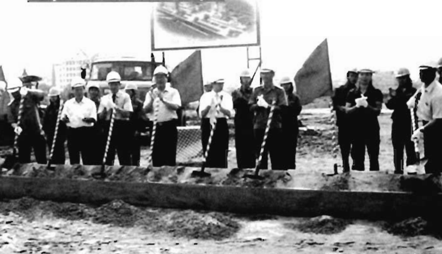
Khởi công KCN Hoà Nội tại huyện Phù Cát (Bình Định)
