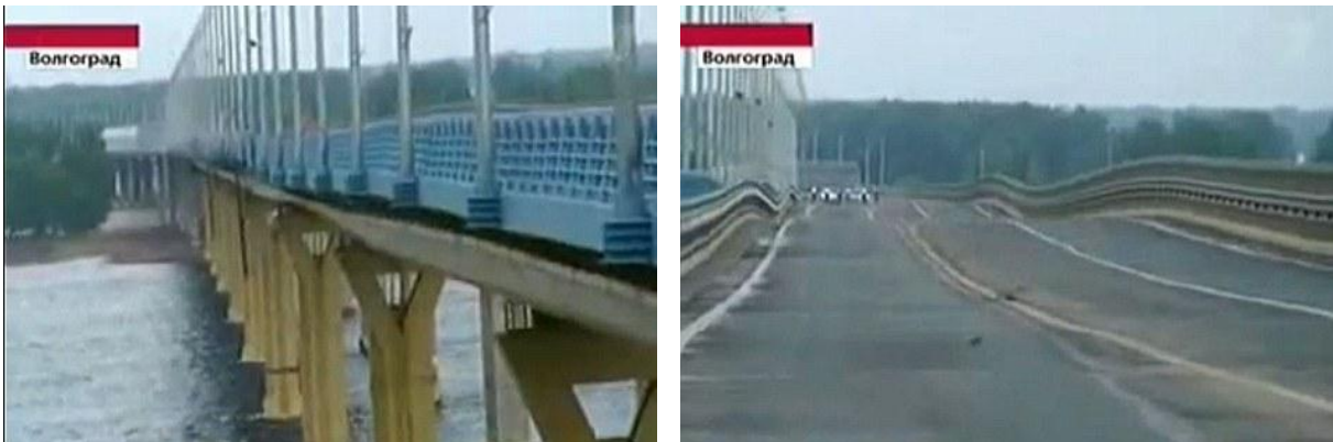
Hình 1.3 Hình ảnh cây cầu Volga-I “nhảy múa” (nguồn: internet)
