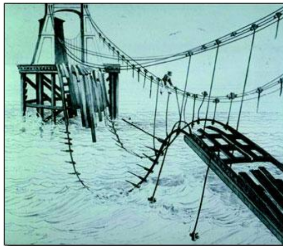
Hình 1.1 Hình ảnh cầu Brighton Chain Pier sau khi bị bão phá hủy vào năm 1836 (nguồn: Internet)
